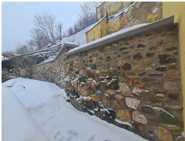
Sanácia oporného múru za Berggerichtom
