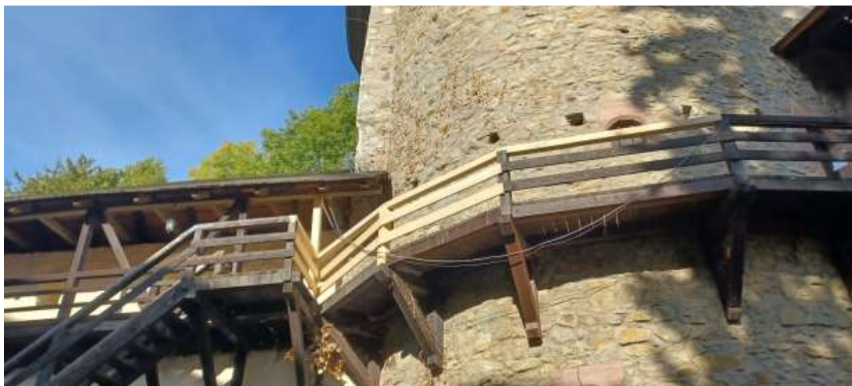
Oprava ochodzí, Starý zámok
