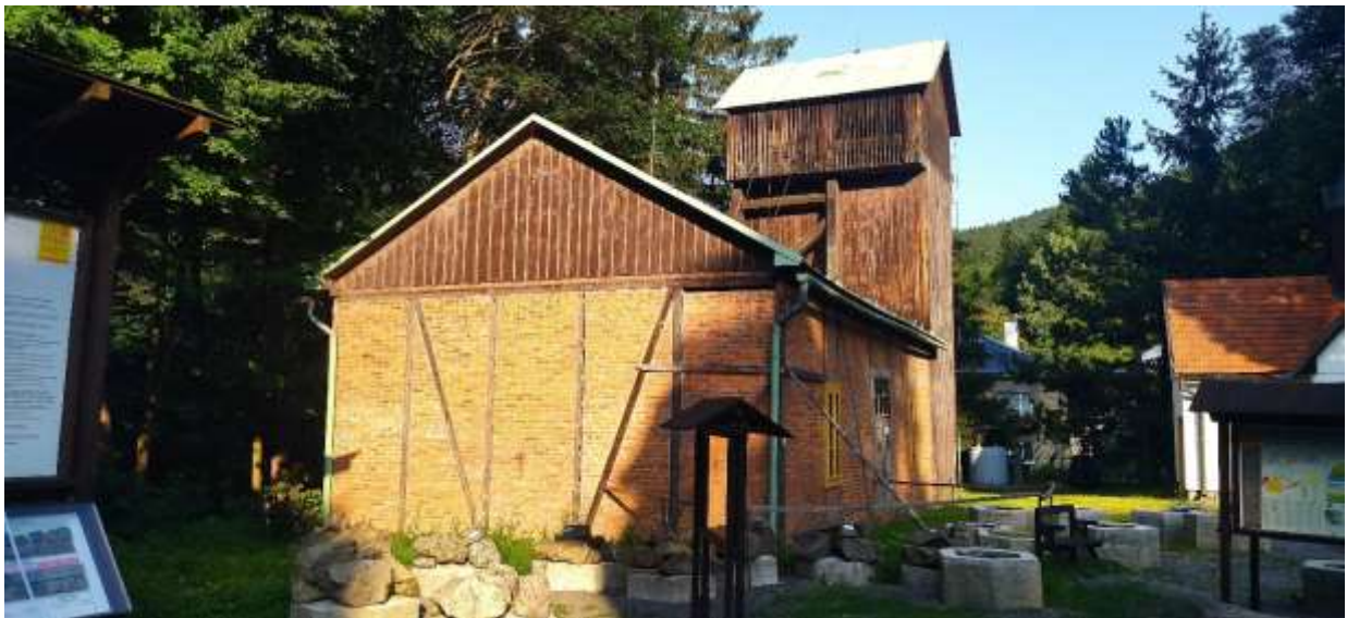
Havarijný stav objektu Šachta Mária, Banské múzeum v prírode
